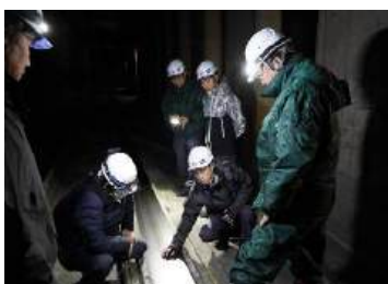
地下鉄走行路補修 R5.9.5～R6.3.12
