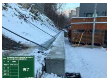
札幌環状線法面補修工事 R6.3.26～R7.1.29
