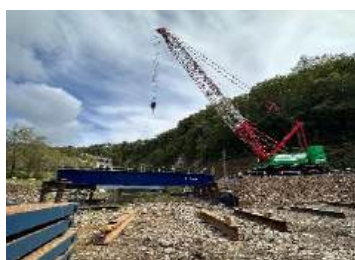
雨竜川ダム仮橋設置工事 R6.65～R6.12.20
