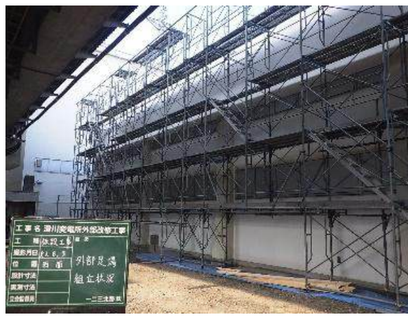
澄川変電所外部改修工事
