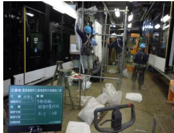
電車事業所工場棟煙突内部解体工事
