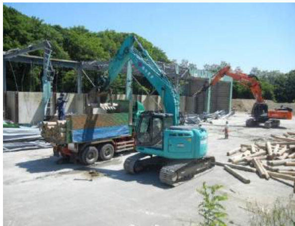
水道水源水質保全発生土管理施設解体工事
