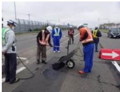
舗装欠損部補修
