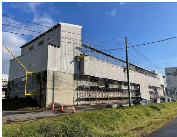
ごみ資源化工場屋根改修工事
