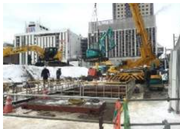
北5条下水道新設 R4.4.1～R5.6.18
